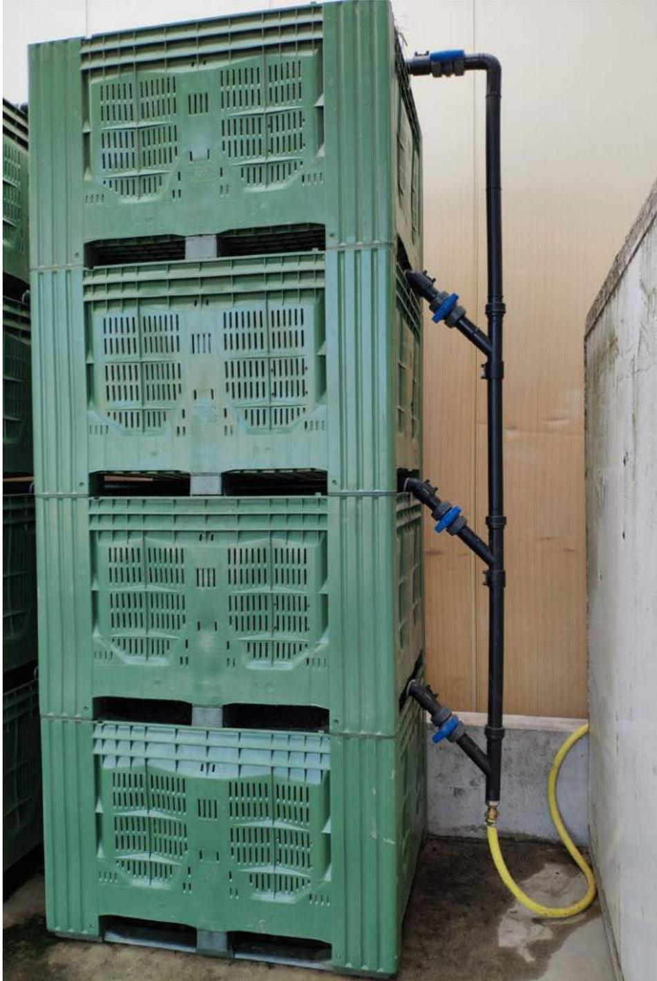
Abbildung 17: Vertikales Verdunstungssystem mit Bodensubstrat in Großkisten (Bern, Schweiz)
